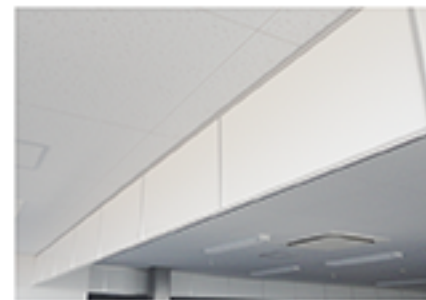
バリアウォール施工完了(不燃メラミン化粧板)
